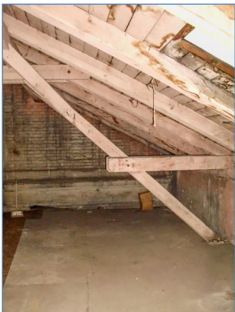
Obr.č. 11 – šikmá vzpěra ležaté stolice podélně ztužená párem kleštin zakotvených do pozednice
