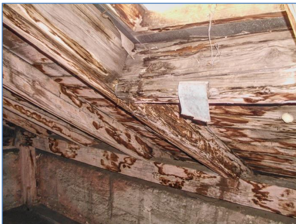
Obr.č. 25 – polodetail havarijní biotické destrukce krokve a pozednice, vč. revizního otvoru
