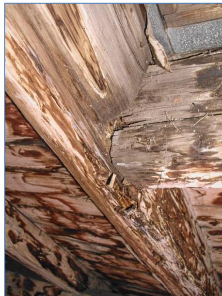
Obr.č. 26 – detail havarijní biotické destrukce krokve a pozednice, vč. revizního otvoru
