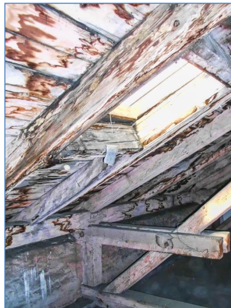
Obr.č. 24 – havarijný stav střešní konstrukce u revizního otvoru (směr do ulice)
