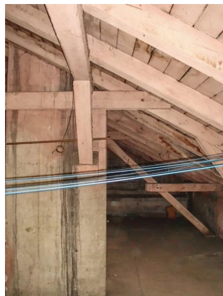
Obr.č. 8 – pásky jsou vyneseny na komínovou výměnu
