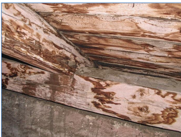
Obr.č. 27 – osedlání krokve na pozednici, která je vynesena zděnou podezdívkou
