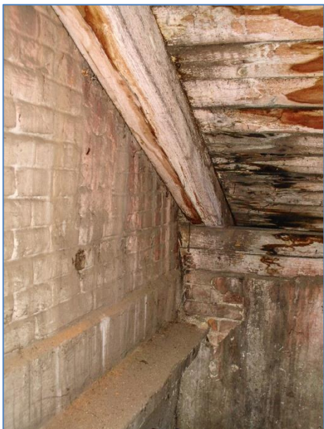
Obr.č. 17 – uložení pozednice u štítové zdi (zděná nadezdívka)
