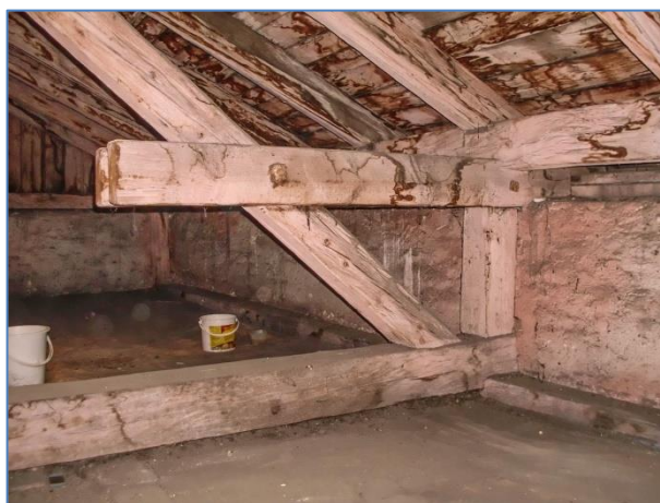
Obr.č. 28 – pohled na spodní kleštiny
