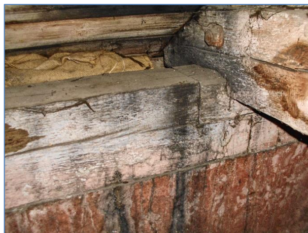
Obr.č. 16 – detail styku pozednice ze spodními kleštinami
