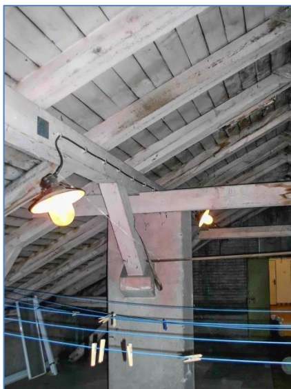
Obr.č. 7 – pásky jsou vyneseny na komínovou výměnu
