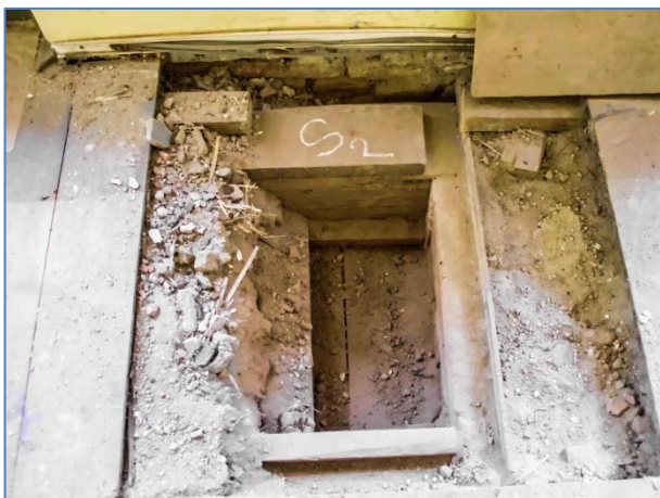
Obr.č. 41 – sonda S2 na spodní straně ST je umístěna střešní lať na které byla položena dřevotřísková deska nesoucí zásyp
