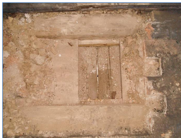
Obr.č. 36 – pohled do sondy S1 – stropní trámy jsou souběžné s obvodovým zdivem
