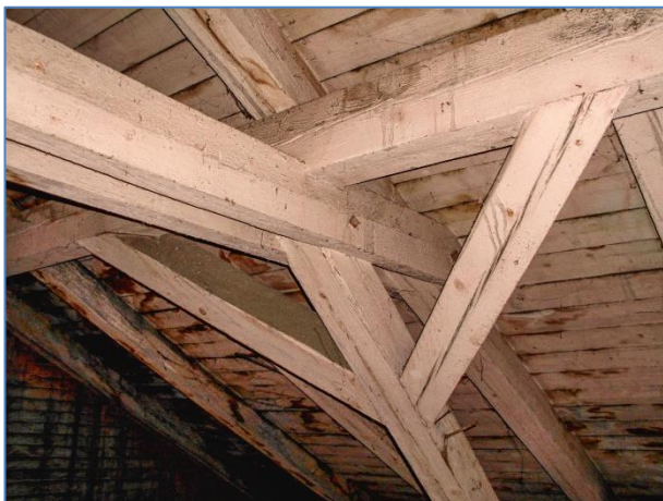
Obr.č. 13 –detail konstr. spoje ležaté stolice (pásky), kleštin a vaznice
