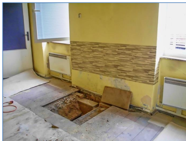
Obr.č. 40 – pohled do sondy S2 – stropní trámy jsou souběžné s obvodovým zdívem
