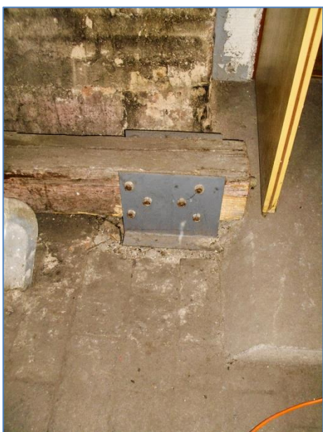
Obr.č. 31 – přerušení vazního trámu (za dveřmi půdního bytu)
