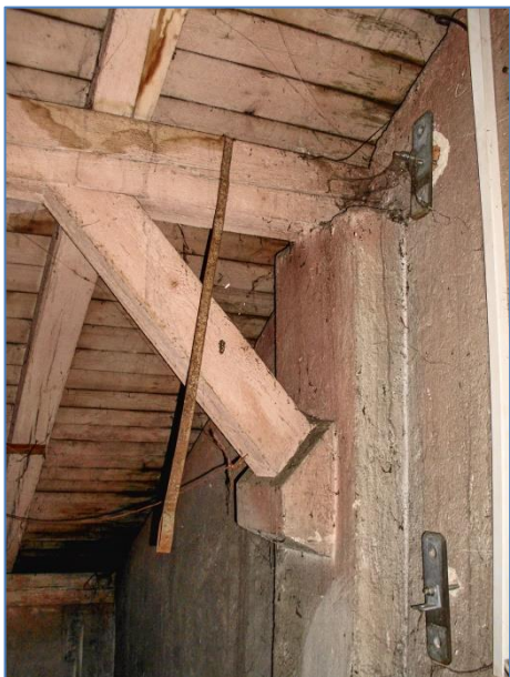
Obr.č. 9 – uložení pásu na štítové zdi
